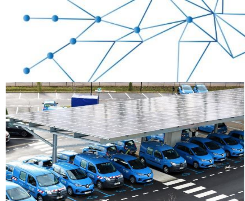
Site Enedis de Limoges : test prévu de synchronisation PV - VE
